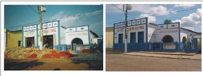
Figura 19 – Bem imóvel com novo proprietário e abertura de duas portas na fachada frontal para fins comerciais.
