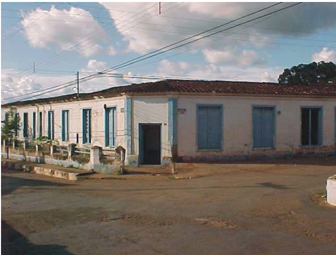
Figura 9 - Antigo Hospital Geral e antiga sede da Prefeitura Municipal. Fonte: FONSECA, 2004.
