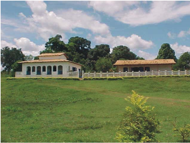
Figura 5- Casa de propriedade original do Sr. João Epifânio da Costa Marques, apresenta características de chácara Fonte: FONSECA, 2004.
