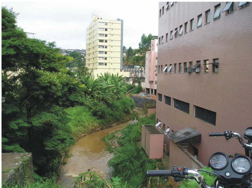
Figura 03 – Edificação próximas ao curso d'água.
