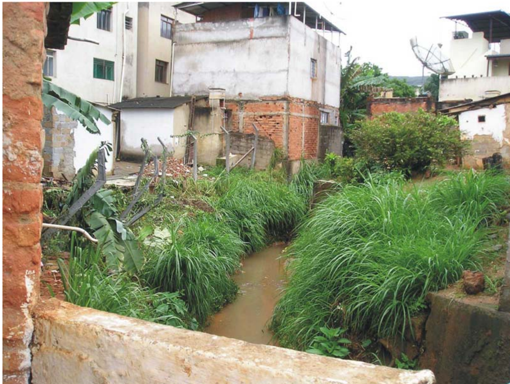
Figura 01 - Edificação próximo ao curso d'água.
