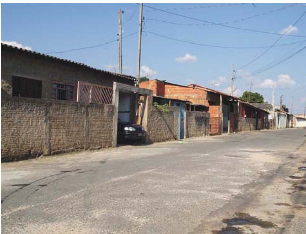
Figura 3. Ocupação irregular nas margens do Ribeirão Samambaia
