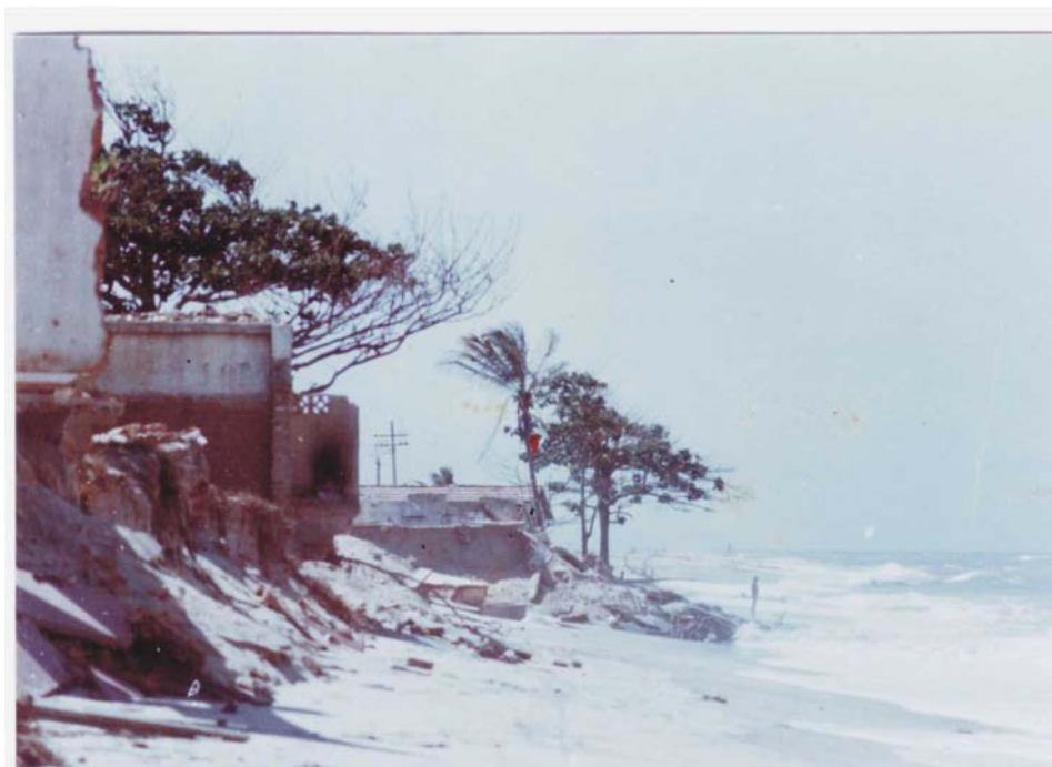
Figura 8 – O contínuo trabalho erosivo no pontal de Atafona
