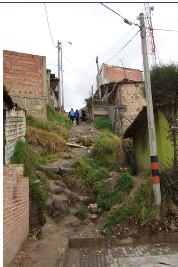
Acceso precario a viviendas estrato 1
