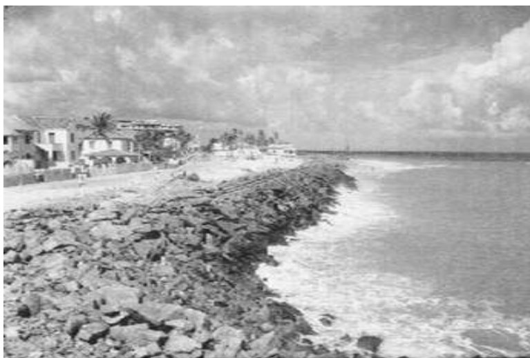
Figura 9 – Praia de Iracema na década de 1960, evidenciando os enrocamentos rochosos construídos para inibir a erosão provocada pelo porto do Mucuripe. Fonte: Arquivo Nirez
