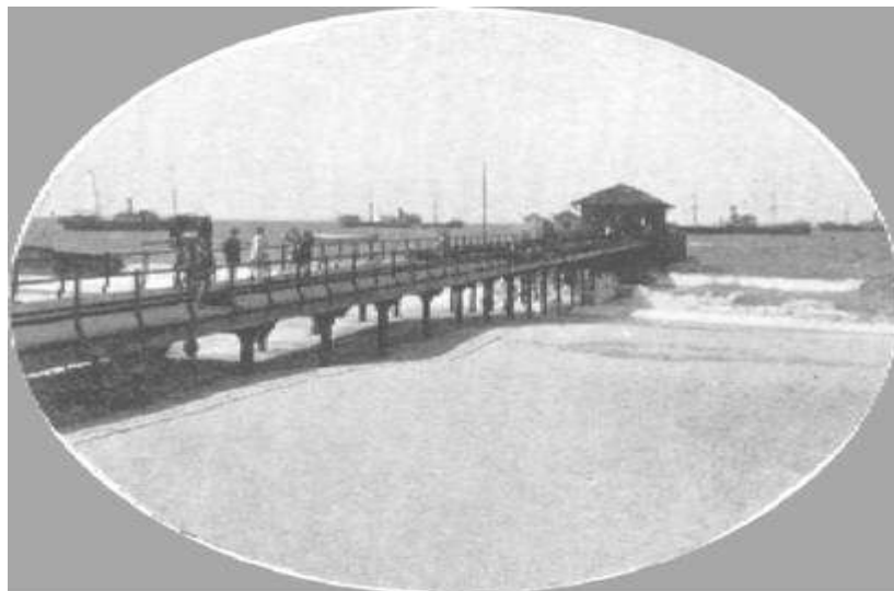
Figura 3 – Ponte Metálica, Praia de Iracema, na década de 1930. Fonte: Arquivo Nirez
