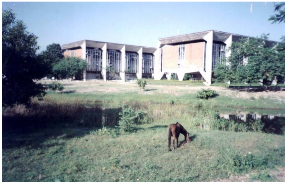
Foto 5: Área de várzeas edificações do Centro Administrativo de Teresina- Piauí. Fonte: Silva, (2004).
