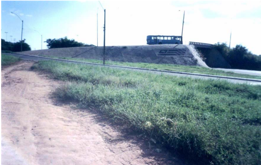
Foto 6: Viaduto no Bairro Parque Rodoviário em Teresina-Piauí. Fonte: Silva, (2004).
