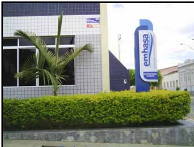
Foto : Naiara de Souza
