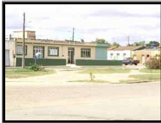
Hospital e Maternidade São Mateus: Bairro Lagoa Comprida Foto 14- Equipamentos de Saúde
