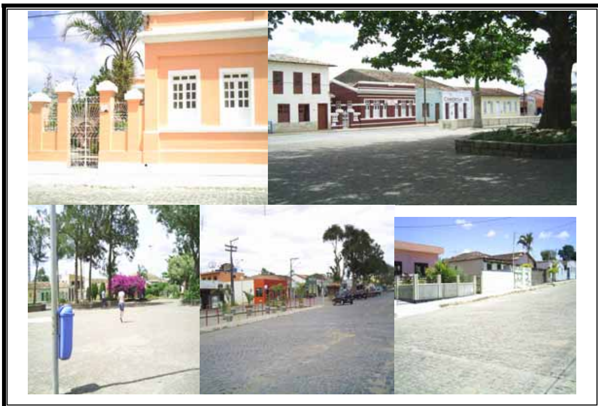
Foto 6-. Ruas pavimentadas, bom nível residencial.
