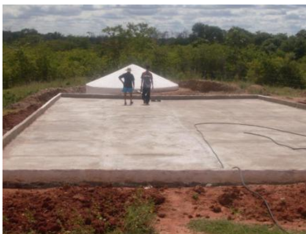
Foto 4: Fase de conclusão da Cisterna Calçadão no Sítio Vaca Morta, Cajazeiras, 2010
