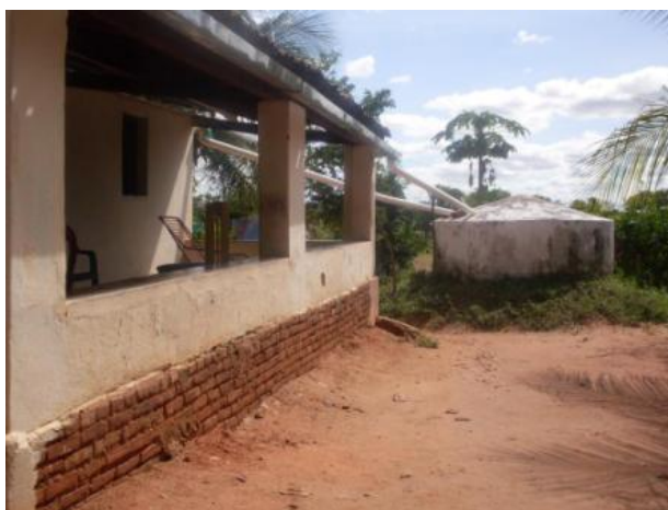
Foto 1: Cisterna de placa no Sítio Vaca Morta. Cajazeiras, 2010
