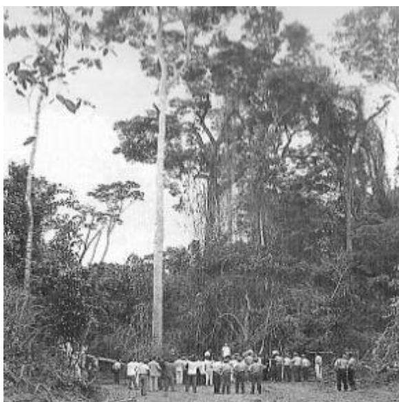
FIG. 4. Última árvore a ser cortada para união dos dois lados da Belém-Brasília. Fonte: PENTEADO, 1998.
