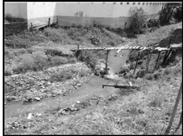
**Figura 9:** Trecho assoreado do Córrego da Rapadura.
