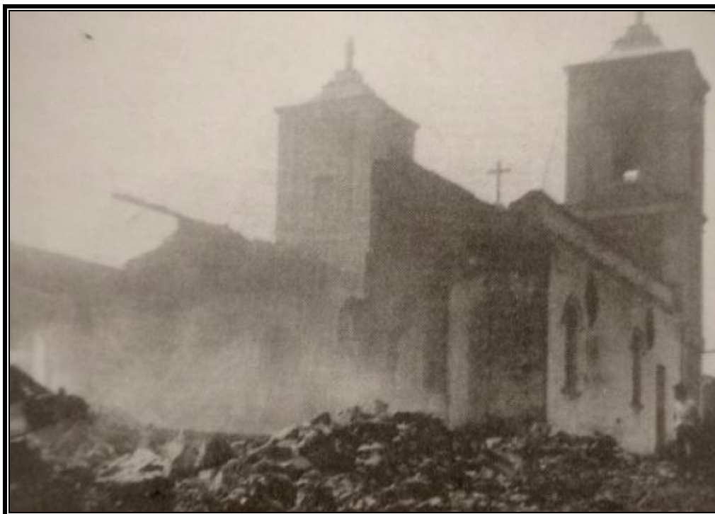
Figura 04: Incêndio na igreja matriz
