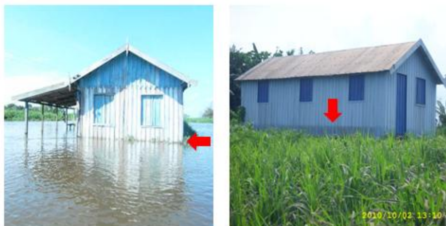
FIGURA 6 e 7: As figuras ilustram o nível da água na maior cheia de 2009, conforme seta vermelha. FOTO: Magalhães, (Neste Trabalho).
