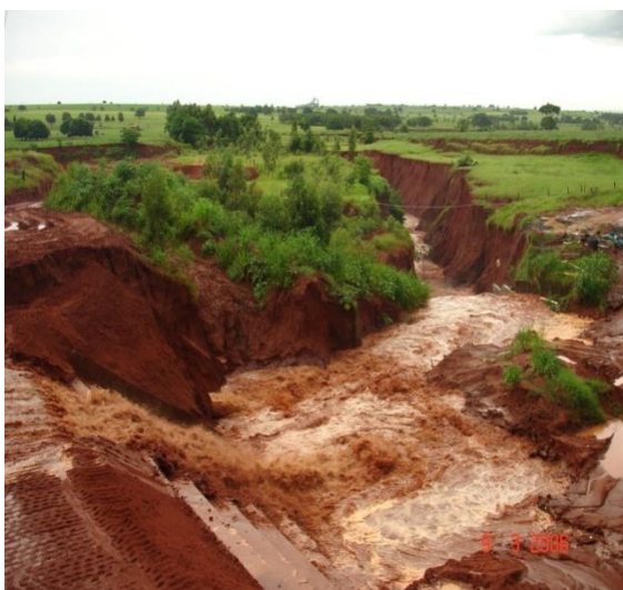
Fig. F: Rompimento da rodovia PR-557 devido o volume de água lançado para o local. (Fonte: Prefeitura Municipal de Terra Rica, 2006). Fig. G: Aumento do processo erosivo pela ação antrópica que direciona a água para o local (Fonte: Prefeitura Municipal de Terra Rica, 2006).
