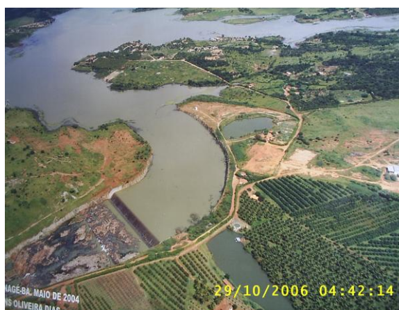
Figura 2: Barragem de Anagé. Fonte: pesquisa de campo.
