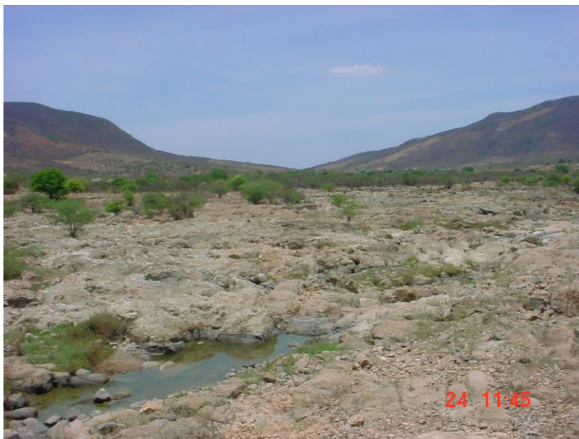
Figura 2–Leito do rio Verde Pequeno a jusante da barragem Espinosa
