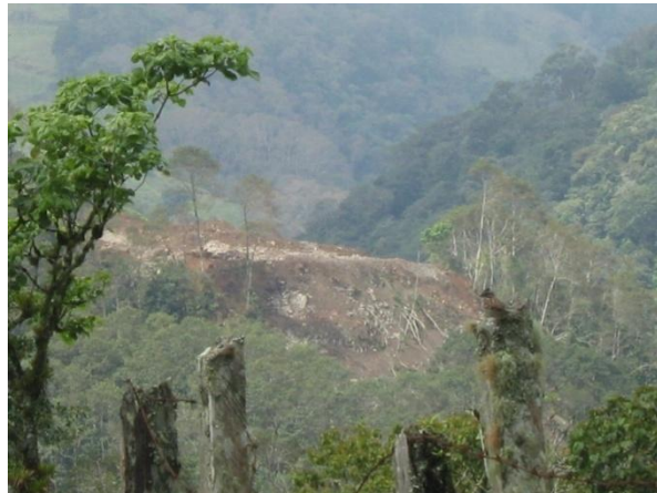
Figura 3. Al fondo se aprecia un área que ha sido deforestada y donde se han realizado movimientos de tierra, puesto que se ha decidido construir un nuevo tramo de la carretera que comunica Alto Palomo con Bajos del Toro, atravesando la zona de muy alta fragilidad ambiental.
