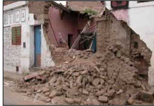
Imagen Nº3: Casa de adobe destruida por el sismo de 7 de Septiembre de 2004. Catamarca. Argentina
