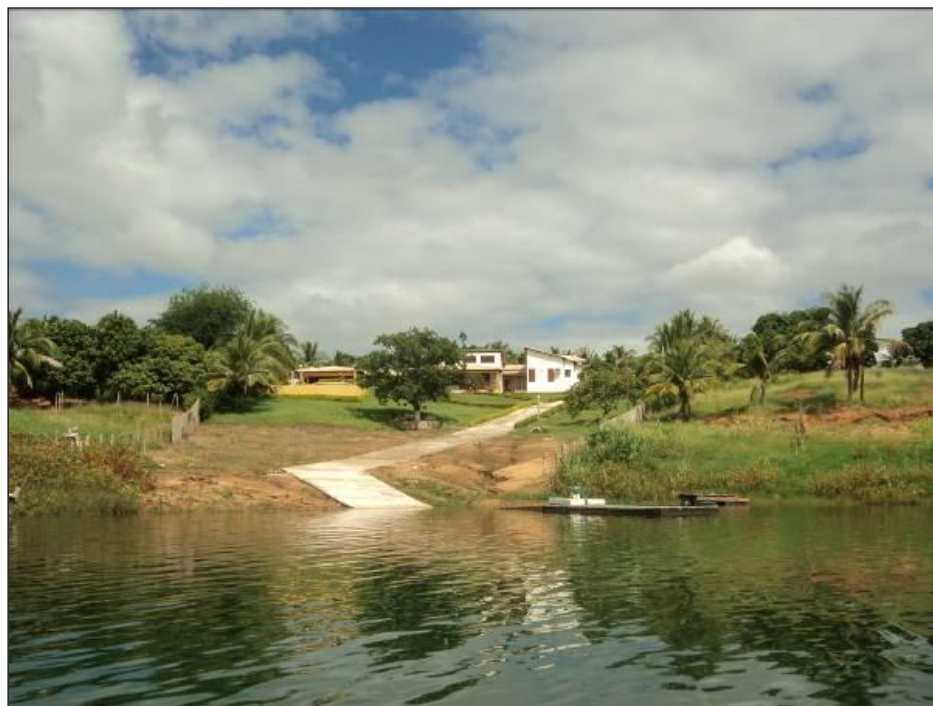
Figura 02. Casa construída após a barragem.
