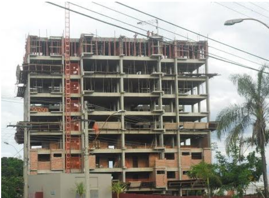
Foto 1: Construção da Hindy, o Buritis. Localizado na Av. Da Saudade, Bairro Mercês . Foto: Amaral, K. F. (2013).
