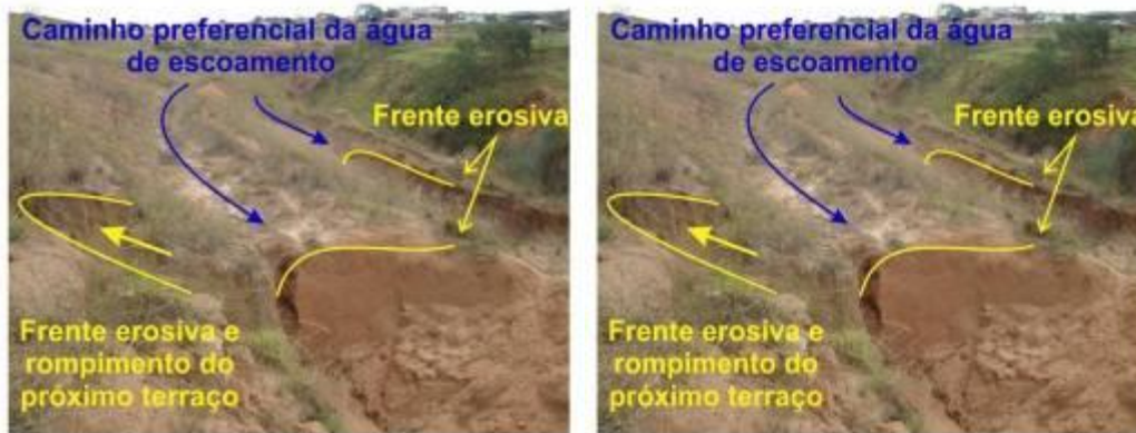
Fig. 3a e 3b – Vetores erosivos condicionados pelos terraços e descontinuidade erosiva, respectivamente.
