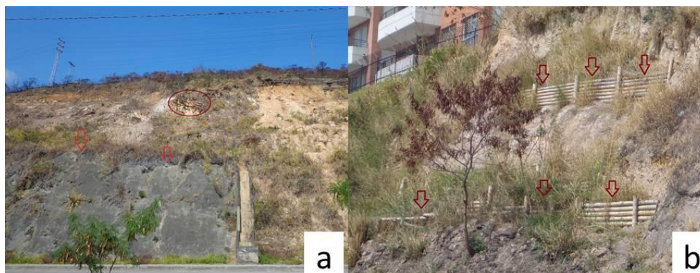
Figura 5. Prevención con muros para la RM. a. Muros de contención en concreto; b. Muros de contención en Guadua.
