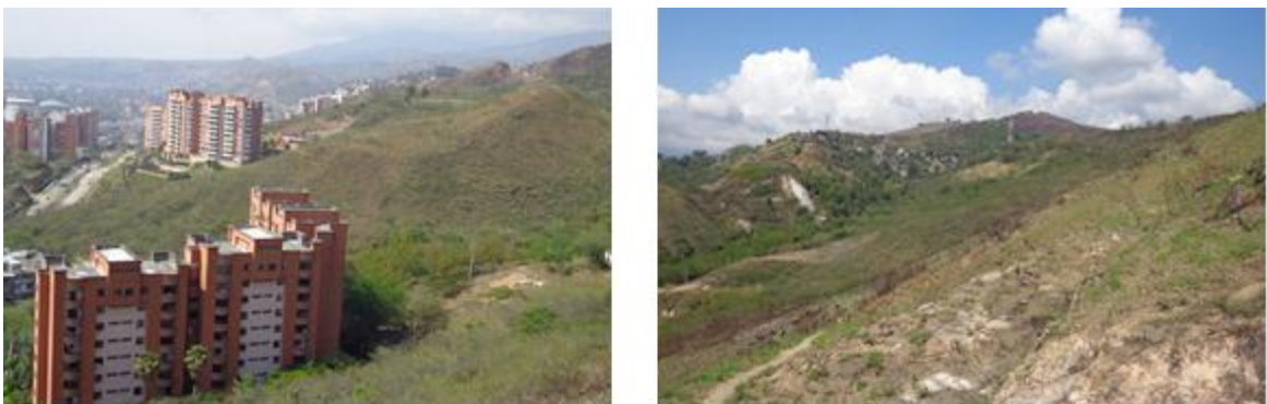
Figura 9. Zona poblada los Cristales. Izq.Zona Poblada de los Cristales; Der.Compactación del suelo.
