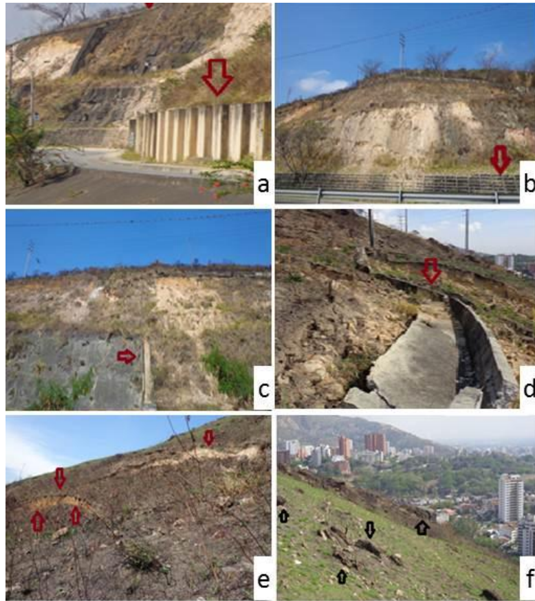
Figura 11. Zona despoblada intermedia. Obras de mitigación realizadas en esta zona para prevenir la RM. a y b . Muros de contención de forma escalonada. c y d . Canales de agua. e . Coronas de remoción y f . Meteorización.
