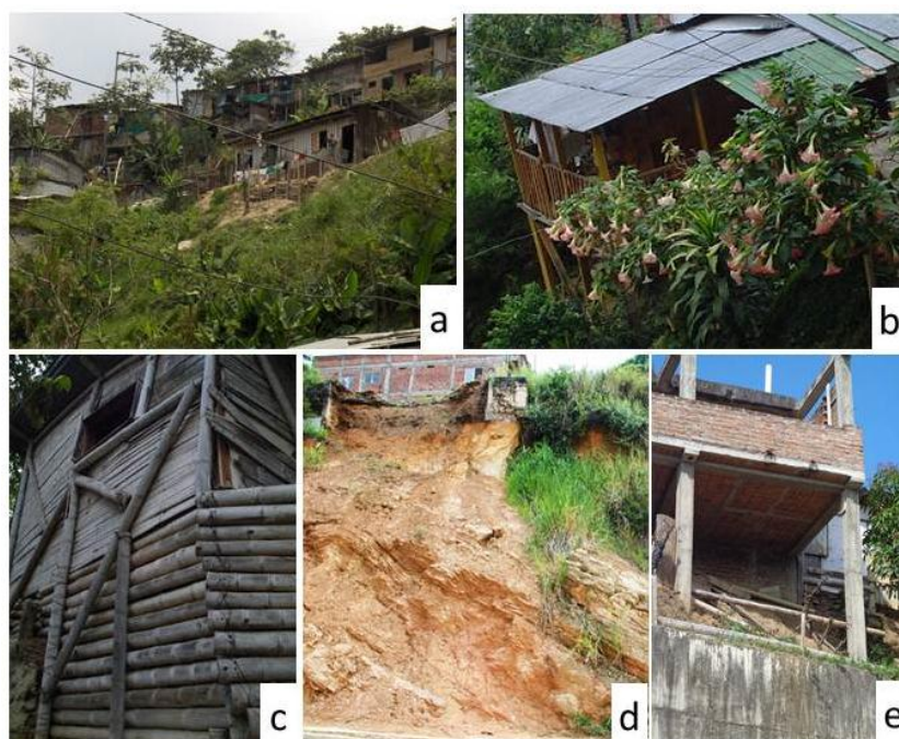
Figura 12. Estado y tipo de vivienda presente en la zona de estudio. a. Panorama general de las viviendas. b y c. Vivienda en madera y guadua. d y e. Construcción en lugares de alto riesgo.
