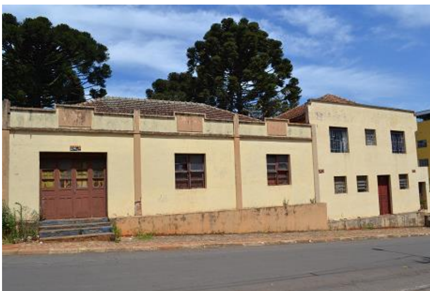
FOTO 03 : Casarão eslavo construído na década de 1950 FONTE: O autor (2014)
