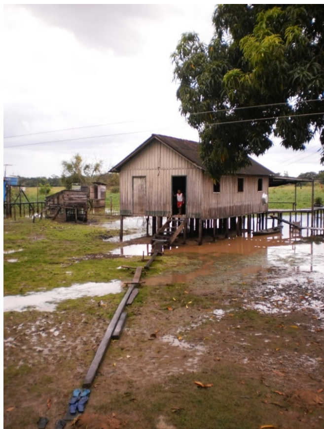
FIGURA 01: Habitação típica das populações residentes no Ecossistema de Várzea. Fonte: Roberth Rodrigues Ferreira. Trabalho de campo, comunidade Ilha de São Miguel, Agosto de 2013.
