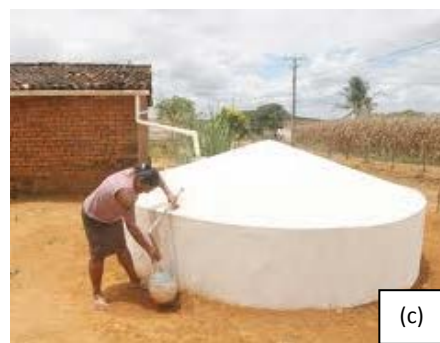
Figura 5 (c) – Cisterna de placa instalada Fonte: http://www.sobralportaldenoticias.com
