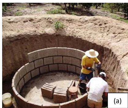
Figura 5 a) Instalação de cisterna de placa Fonte: Brasil, 2011
