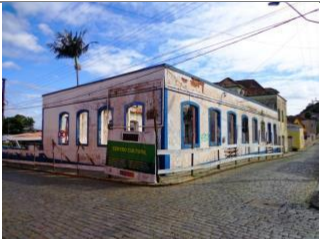
Foto 11. Edifício em processo de recuperação para instalação do Centro Cultural (foto do autor – 11/2014)
