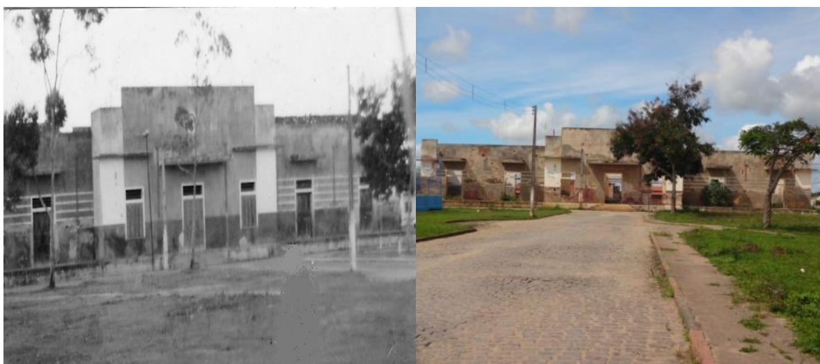
Figura 3: Estação Ferroviária de Castro Alves, 1990 e 2013. Fonte: Acervo dos autores, 2014.
