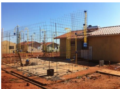
Figura 9: Estrutura de aço prestes a receber concreto.
