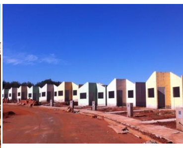
Figura 10: Paredes em concreto armado.
