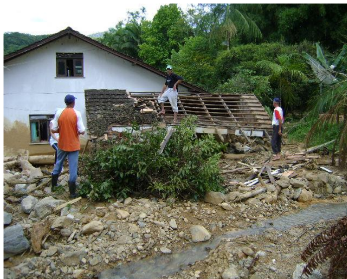
Figura 2 Casa de um agricultor atingida por deslizamento em 2008 Autor: Vidal Reichert, 2008.
