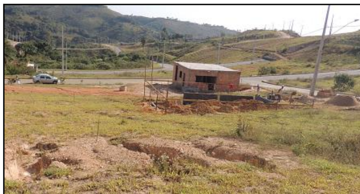
Figura 4: Situação da erosão no dia 22 de maio de 2014 no bairro Bela Vista.
