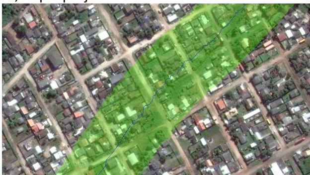
Figura 5 – Trecho que mostra a substituição da vegetação por edificações na área de APP estudada
