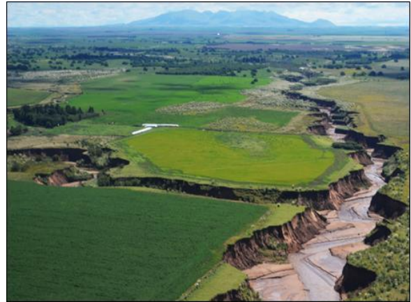
d. Colapso de túneles (piping / sapping)
