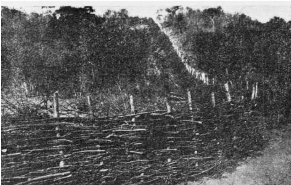
Figura 2. Método usado para fazer cercas.
