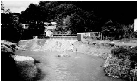
Foto 2. Mesmo local após o episódio de chuvas. A calha duplicou de largura indicando a violência do processo erosivo (foto: Hermínia da Silva Guedes)
