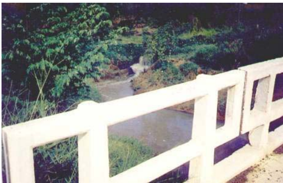
Foto 2 – DERRAMAMENTO DE ESGOTO “IN NATURA”
